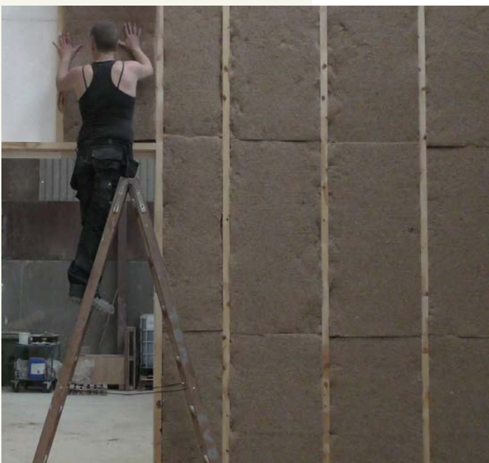
Hørisolering.
