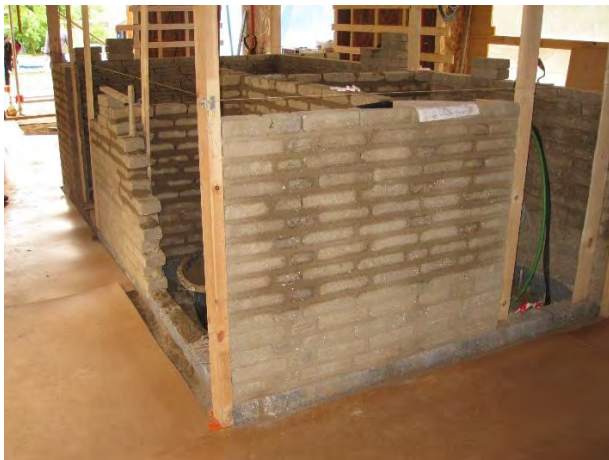
Vådrum og teknikrum er muret op i lersten midt i bygningen
