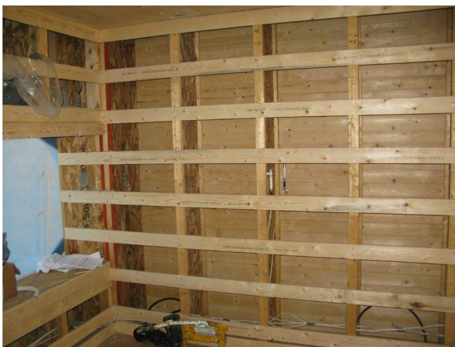
Figur 3. Målepunkt 28 og 29 i facade mod øst.
